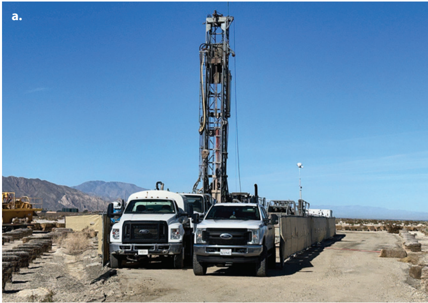
Figura 4. Fisonomía y actividades en el sitio de Clubhouse. a) Perforación de los pozos definitivos en Clubhouse. b) Instalación de tres cruces de Arizona en la ruta de Clubhouse A para mejorar el acceso al sitio. c) Vegetación lista para plantar en Clubhouse B. d) Maduración de la vegetación en Clubhouse B.
