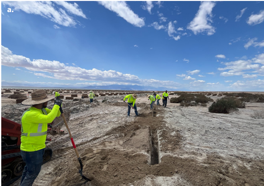
Figura 8. Fisonomía del sitio y actividades en el sitio de West Bombay Beach. a) Instalación de tubería para el sistema de riego por goteo. b) Uso de perforación direccional horizontal para instalar la red de riego. c) Germinación de siembra en plántulas jóvenes sobre las líneas de riego por goteo. d) Crecimiento de la vegetación plantada sobre las líneas de riego por goteo.
