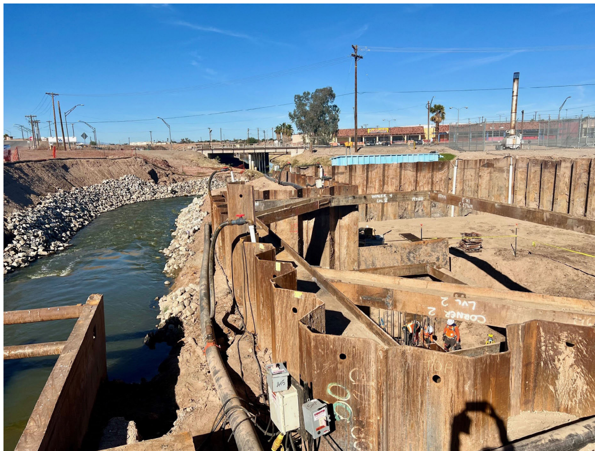
Figura 20. Agua del Río Nuevo desviada en el canal de desvío izquierdo con pilotes de acero y pozos de desagüe para permitir la construcción de un revestimiento de hormigón en el Río Nuevo con un pozo húmedo profundo para capturar el agua del río, que se encerrará en una tubería de 72" de diámetro para transportar aproximadamente 1.5 millas corriente abajo.
