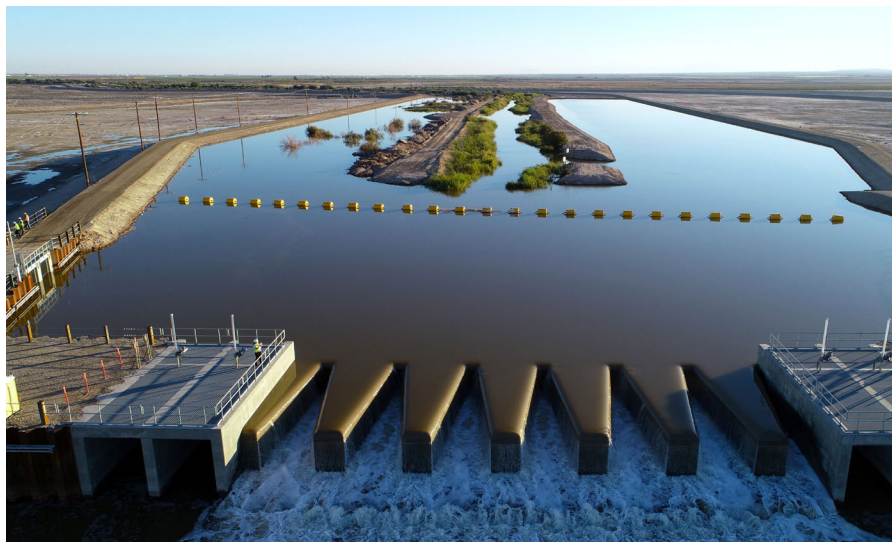
Figura 5. Desvío del Río Nuevo y estructura de entrada en SCH.
