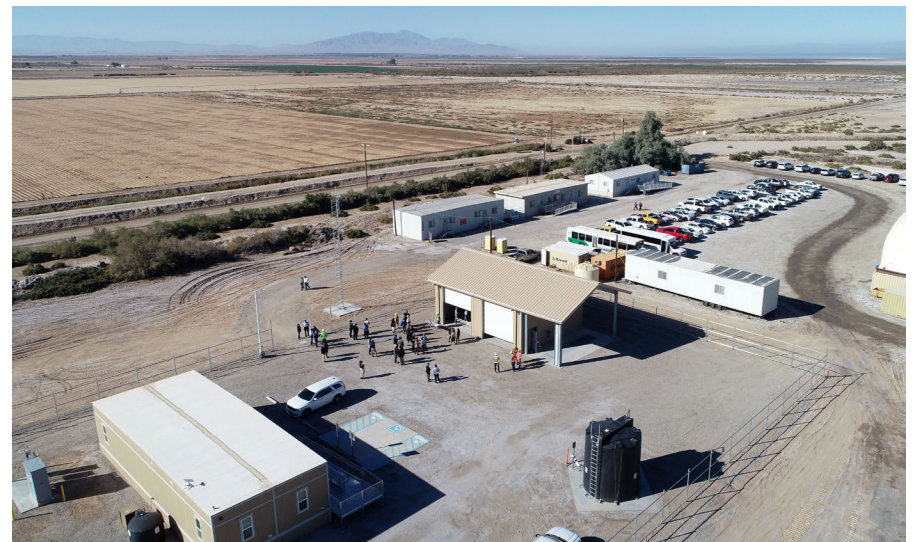
Figura 6. Área de OyM y estructura de garaje en SCH.
