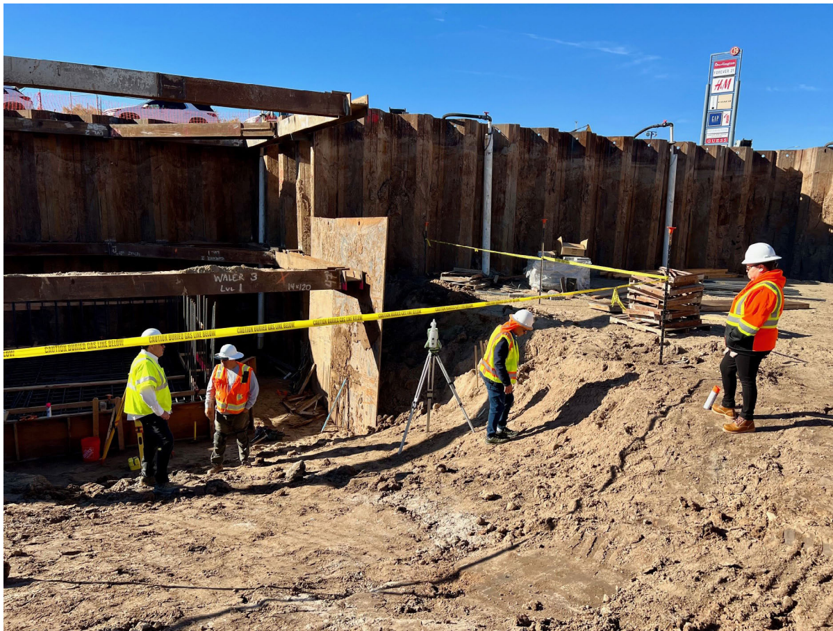
Figura 21. Construcción de pozo húmedo dentro del canal del Río Nuevo, protegido por pilotes de acero y pozos de desagüe. Esta área también incluirá construcción de un canal de hormigón reforzado. Al finalizar las mejoras, se retirarán los pilotes de acero y los pozos de desagüe, se retirará el canal de desvío, y esta área volverá a estar bajo el agua.
