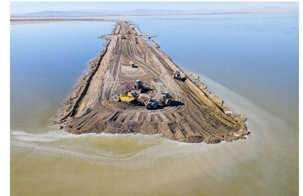
**Figura 7.** Colocación de escollera en el lado del Lago de la berma en la Expansión Estanque Este 1 de SCH.
