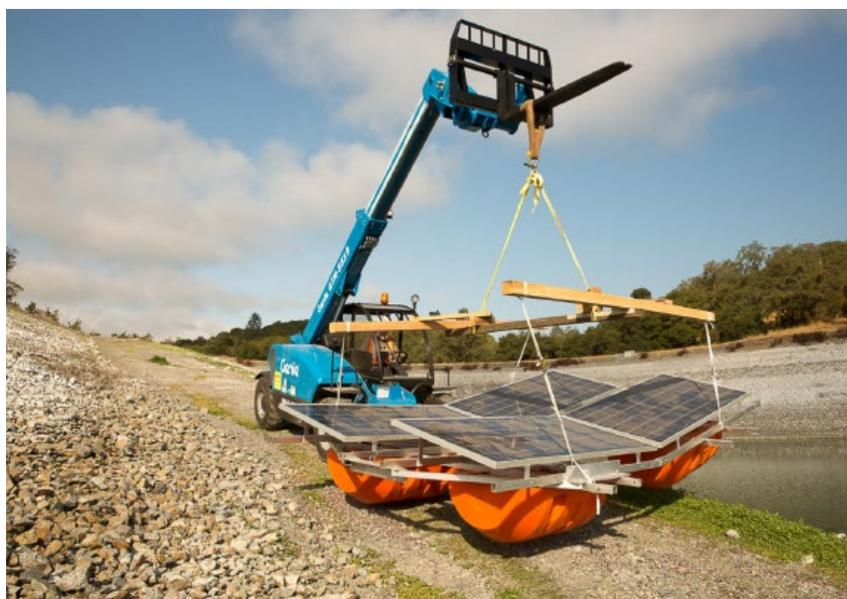
Figura 5-32. Concepto 9A: Sistema Flotante Solar y de Generación de Agua.
